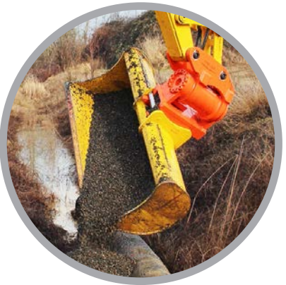
Metering Fill Material
